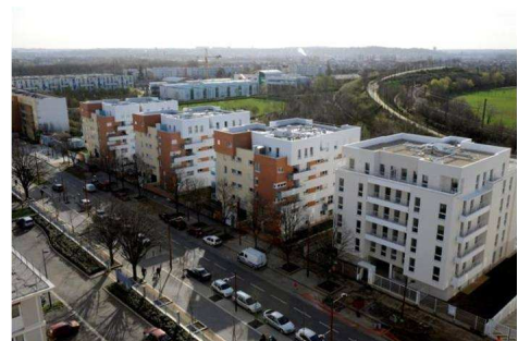
Immeubles collectifs reconstruits à Orly (Parc des Saules) Photo UT-DRIHL
