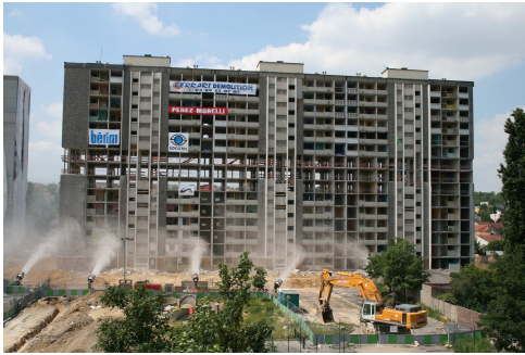
Ci-contre, barre DEF à Vitry-sur-Seine démolie en juin 2010 Photo préfecture/BCIP
